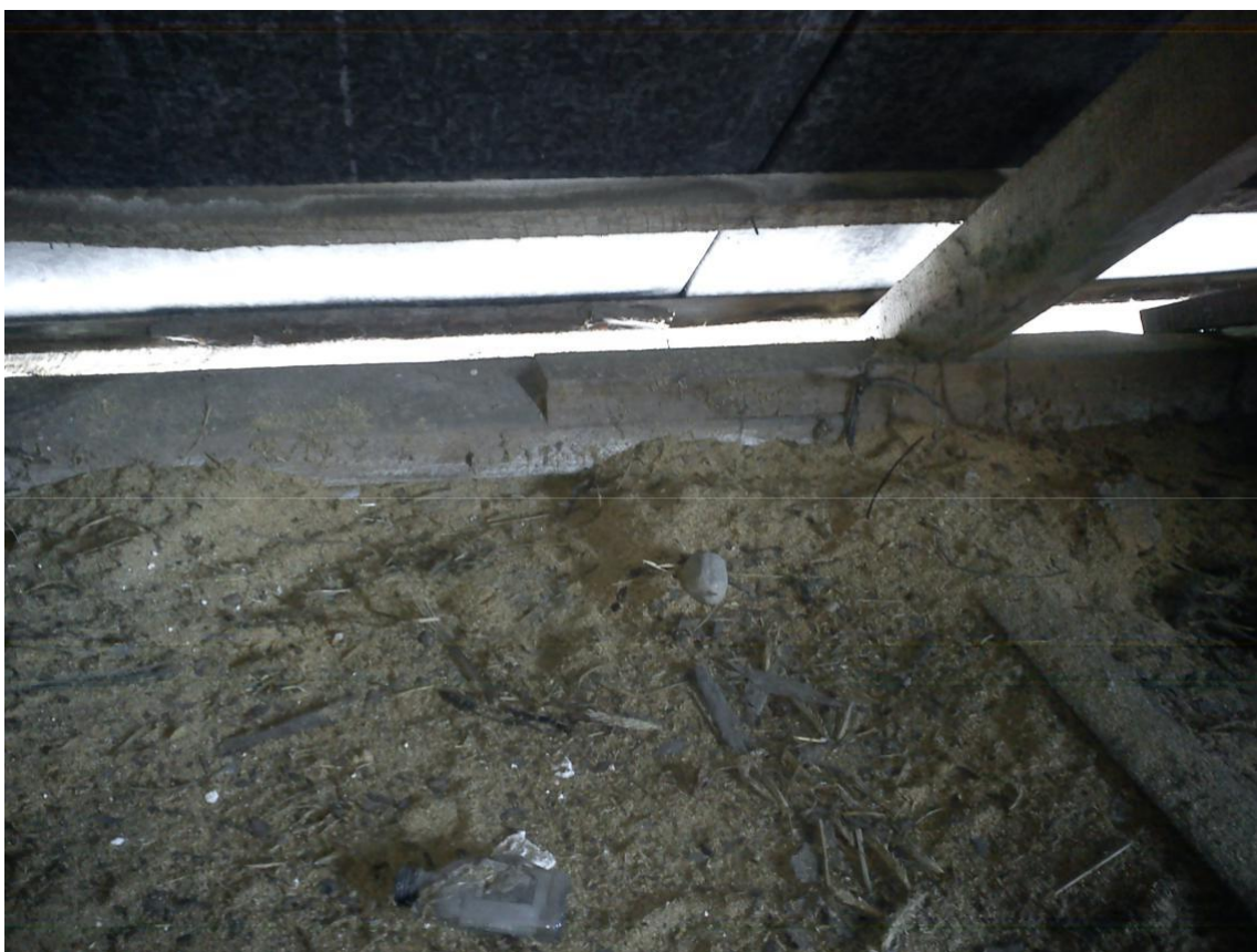
Połączenie murłaty na długości i murłaty z krokwią
