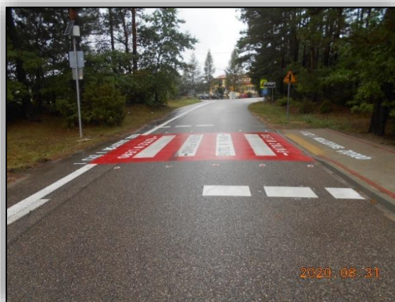
Fot. Budowa przejścia dla pieszych wraz z odcinkiem ciągu pieszego na drodze gminnej nr 250610W w msc. Białobiel
