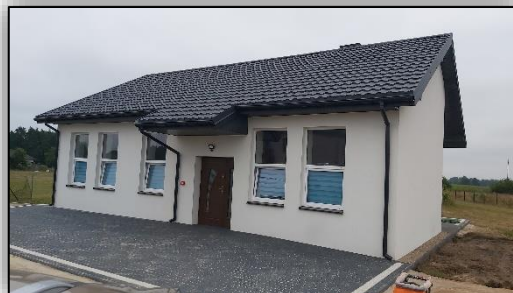
Fot. Rozbudowa i przebudowa budynku zlewni mleka ze zmianą sposobu użytkowania na świetlicę wiejską w msc. Nasiadki
