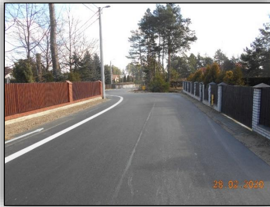
Fot. Rozbudowa dróg gminnych nr 250630W i 250632W w msc. Białobiel wraz z budową łącznika
